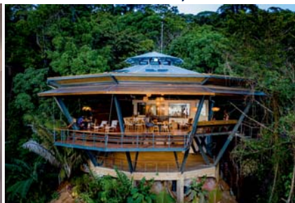
La Casa de las Baterías Energía
